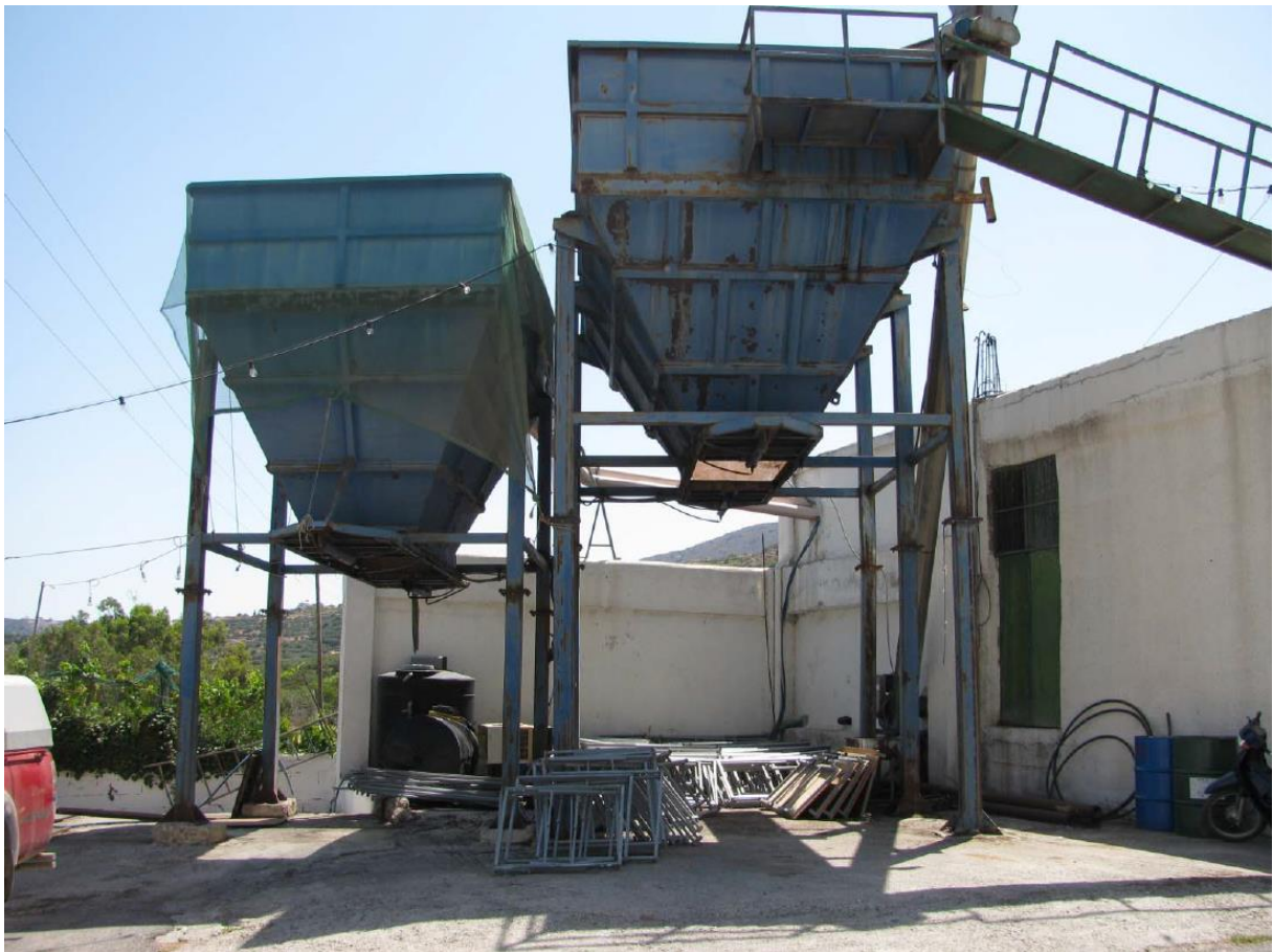
Σιλό αποθήκευσης της πούλλπας (δεξιά) και του σιλό αποθήκευσης των ελαιοφύλλων (αριστερά)
