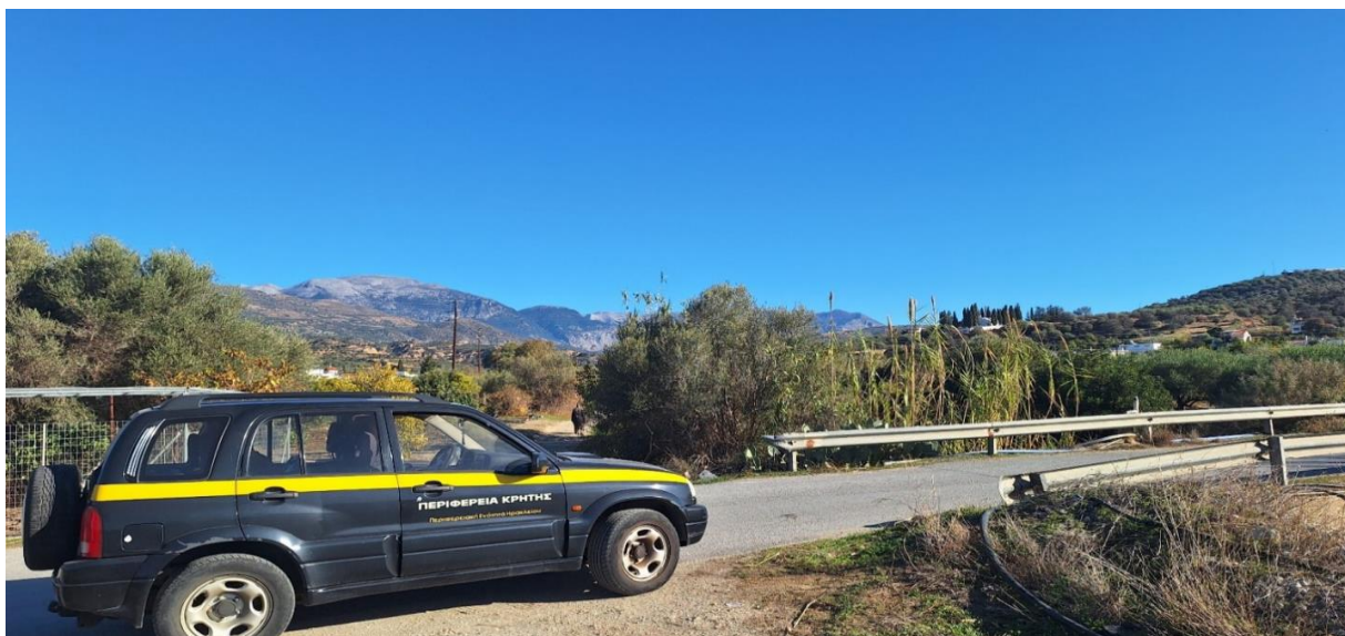
Εικόνα 6: Η γέφυρα Γ3 που πρόκειται να αντικατασταθεί με γέφυρα μεγαλύτερου ανοίγματος
