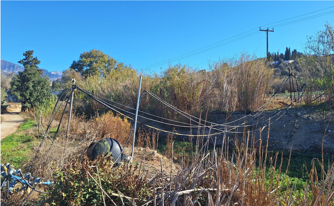
Εικόνα 7: Μέρος του ρέματος το οποίο χρήζει διευθέτησης και καθαρισμού.
