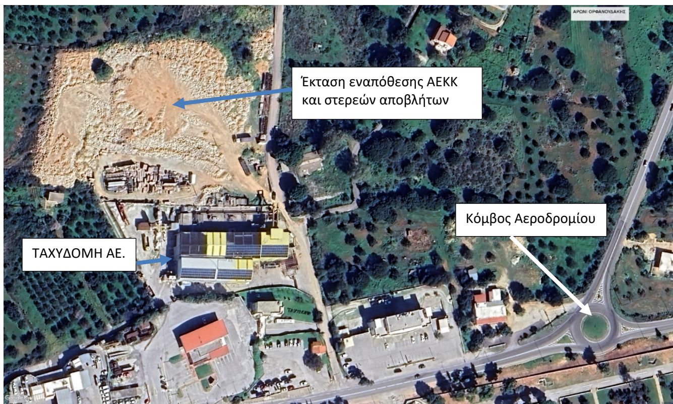
Εικόνα 1: Αεροφωτογραφία από το Google Earth (2-2024) της έκτασης εναπόθεσης αποβλήτων εκσκαφών κατασκευών και κατεδαφίσεων (ΑΕΚΚ), λοιπών στερεών αποβλήτων και οικοδομικών υλικών στην περιοχή «Παζινός» Δ.Ε. Ακρωτηρίου του Δήμου Χανίων.
