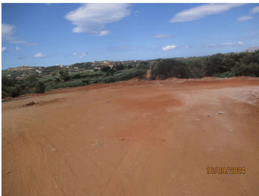
Φωτ. 1. Απομάκρυνση προϊόντων εκσκαφών και κατεδαφίσεων από το αγροτεμάχιο ιδιοκτησίας ΥΙΟΙ ΑΝΑΣΤΑΣΙΟΥ ΤΖΙΚΑ Ο.Ε.
