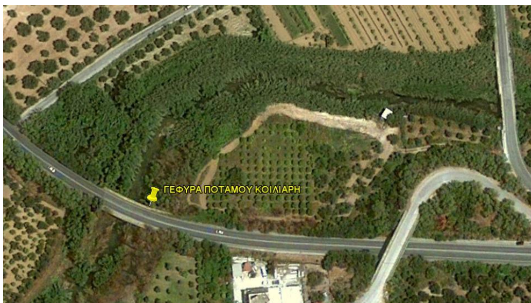
Αεροφωτογραφία GOOGLE της γέφυρας ποταμού Κοιλιάρη επί του Β.Ο.Α.Κ.
