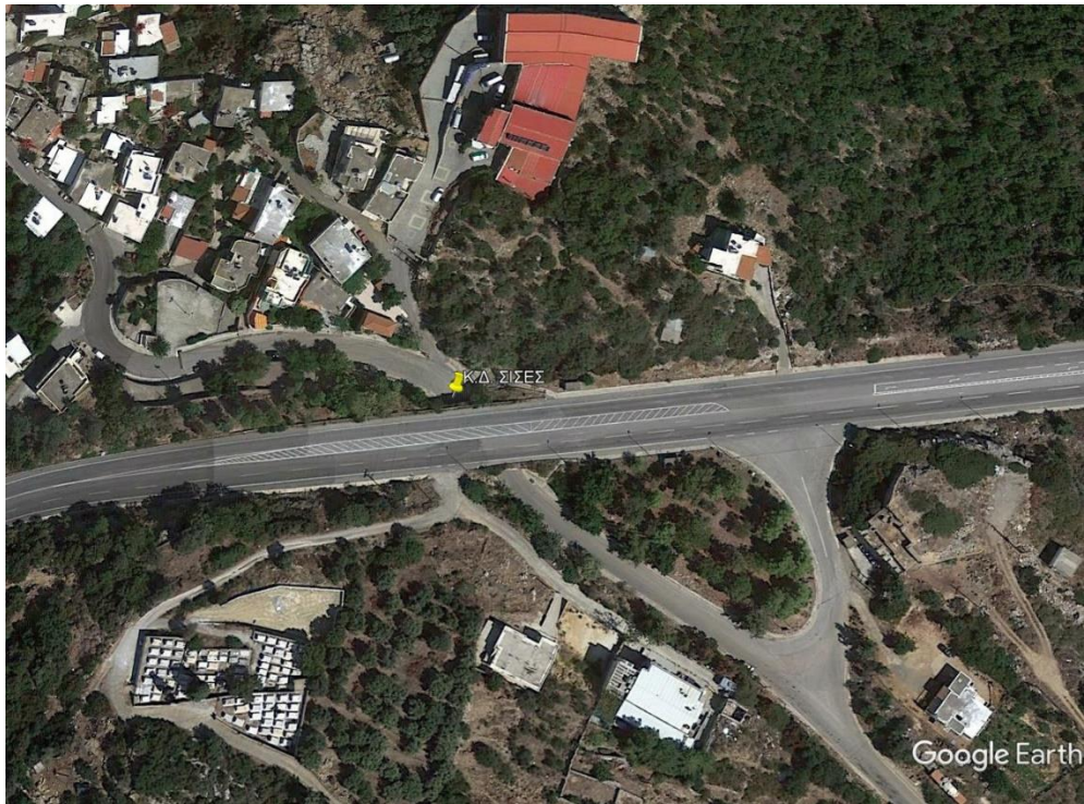
Αεροφωτογραφία GOOGLE στη θέση της γέφυρας Κ.Δ. προς Σίσεσ
