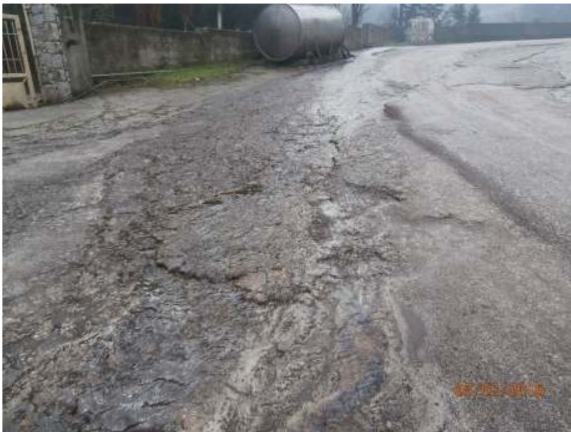
Φωτ. 2. Όδευση ομβρίων με στραγγίσματα στο δρόμο που οδηγεί στο χώρο παραλαβής (05-02-2016)
