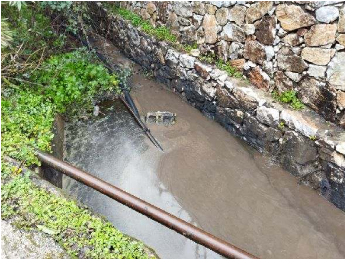
Φωτ. 3. Διαρροές στραγγισμάτων εκτός της εγκατάστασης (13-01-2022).
