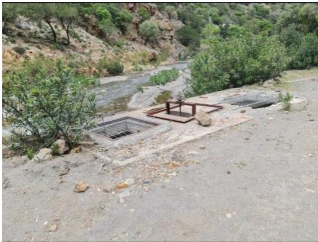
Εικόνα 14-5 φρεάτια καταθλιπτικού αγωγού άρδευσης
