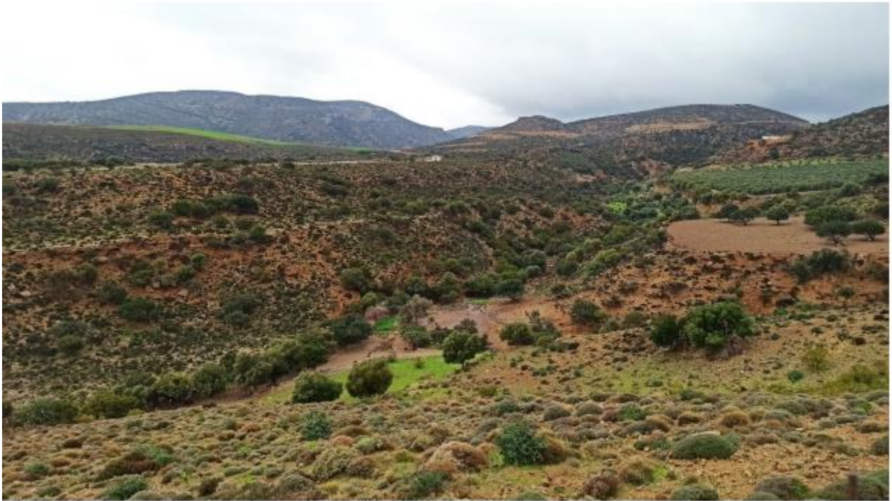
Εικόνα 14-12 Γενική άποψη της περιοχής κατασκευής της νέας λιμνοδεξαμενής. Όψη προς τα Β-ΒΔ.
