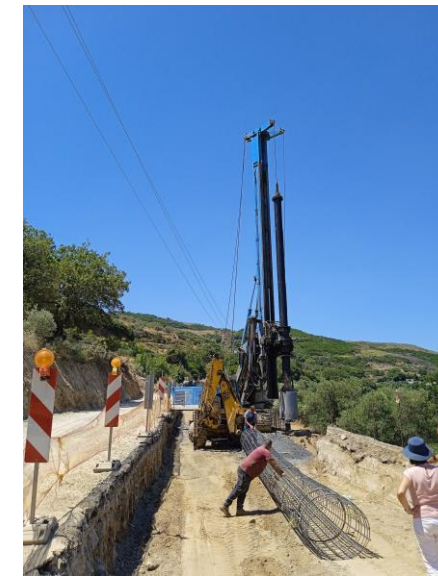
ΕΠΕΙΓΟΥΣΕΣ ΕΡΓΑΣΙΕΣ ΑΠΟΚΑΤΑΣΤΑΣΗΣ ΖΗΜΙΩΝ ΣΤΑ ΟΔΙΚΑ ΤΜΗΜΑΤΑ Β.Ο.Α.Κ.- ΕΠΙΣΚΟΠΗ - ΜΥΡΙΟΚΕΦΑΛΑ - ΌΡΙΑ ΝΟΜΟΥ ΧΑΝΙΩΝ, ΑΡΓΥΡΟΥΠΟΛΗ - ΟΡΙΑ ΝΟΜΟΥ ΧΑΝΙΩΝ
