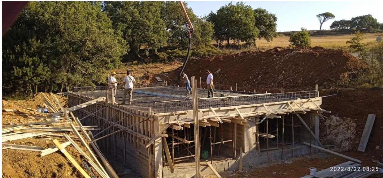
ΕΠΕΙΓΟΥΣΕΣ ΕΡΓΑΣΙΕΣ ΑΠΟΚΑΤΑΣΤΑΣΗΣ ΖΗΜΙΩΝ ΣΤΟ ΔΡΟΜΟ ΠΛΑΤΑΝΕΣ-ΚΥΡΙΑΝΝΑ-Ι.Μ. ΑΡΚΑΔΙΟΥ ΚΑΙ ΣΥΝΔΕΟΜΕΝΟΙ ΔΡΟΜΟΙ
