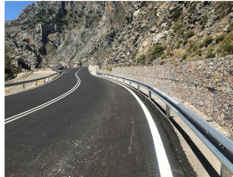
ΠΡΟΣΤΑΣΙΑ ΕΠΑΡΧΙΑΚΟΥ ΟΔΙΚΟΥ ΔΙΚΤΥΟΥ ΑΠΟ ΒΡΑΧΟΠΤΩΣΕΙΣ ΣΤΟ ΦΑΡΑΓΓΙ ΚΟΥΡΤΑΛΙΩΤΗ
