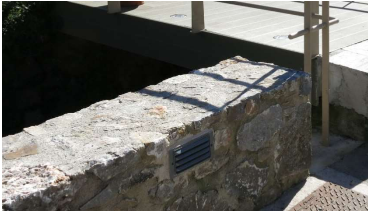
Εικ.31 Προτεινόμενα χωνευτά φωτιστικά επί τοίχου
