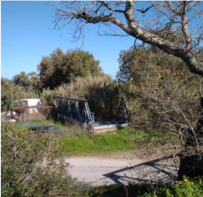
Εικ.15 Το αποκομμένο τμήμα της μεταλλικής γέφυρας που μπορεί να τοποθετηθεί εντός της νέας πλατείας.
