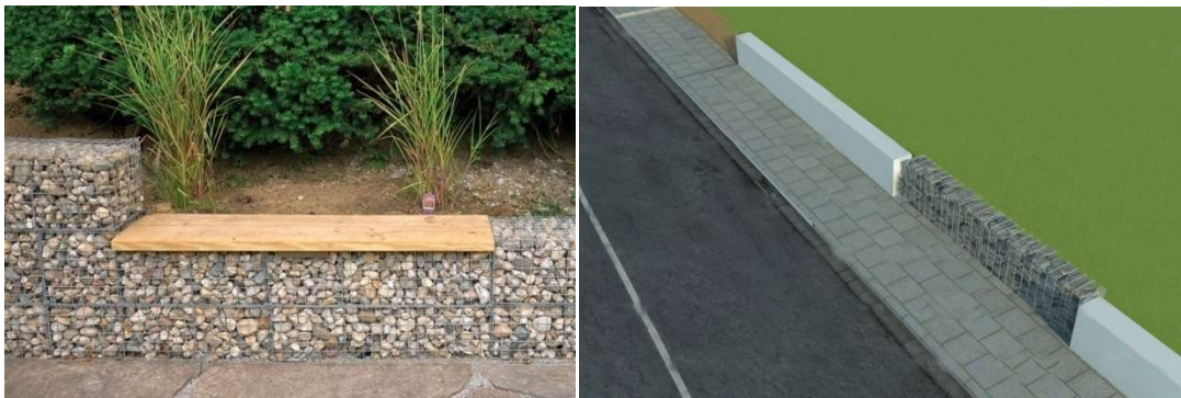
Εικ.26-27 Οι κατασκευές με συρματοκιβώτια για την αντιστήριξη πρανών στην περιοχή
