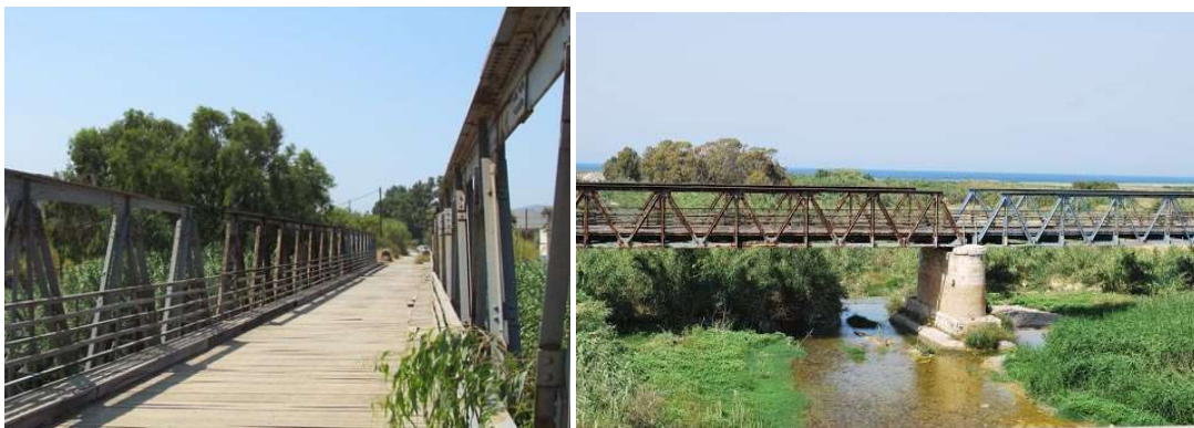
Φ.05 - Φ.06 Μεταλλική παλιά γέφυρα Ταυρωνίτη
