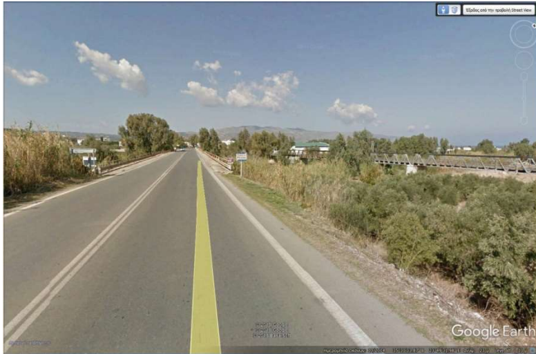
Φ.04 Γέφυρα Ταυρωνίτη και παλαιά μεταλλική γέφυρα στο βάθος
