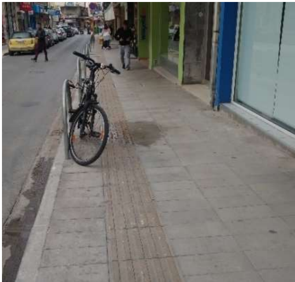
Εικ.25 Χαρακτηριστική εικόνα πεζοδρομίου με οδηγό όδευσης τυφλών και προστατευτικά Π.
