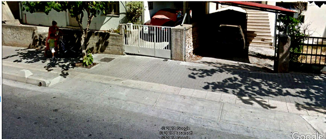
Εικ.28 Ράμπες εισόδου ιδιοκτησιών με βιομηχανικό δάπεδο
