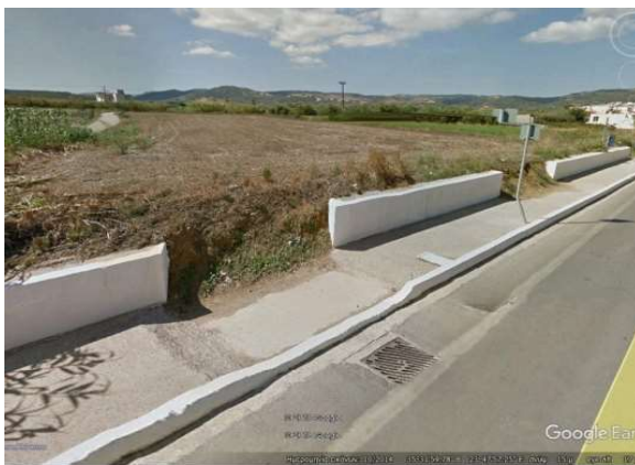
Φ.18 Υφιστάμενα προστατευτικά τοιχία ιδιοκτησιών.
