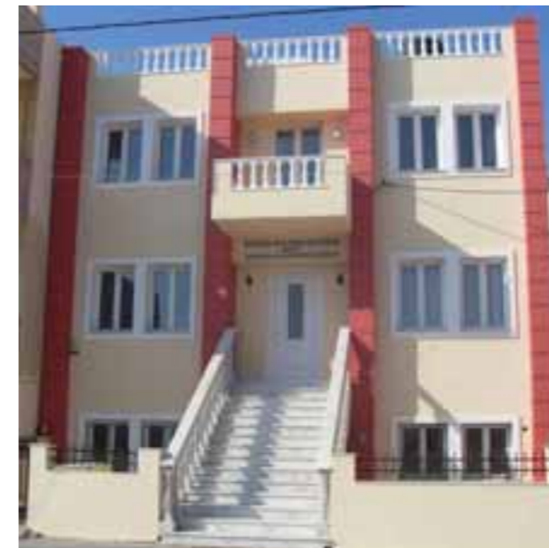
ΚΕΝΤΡΟ ΔΗΜΙΟΥΡΓΙΚΗΣ ΑΠΑΣΧΟΛΗΣΗΣ ΚΑΙ ΕΚΦΡΑΣΗΣ ΠΟΛΙΤΙΣΤΙΚΟΥ ΣΥΛΛΟΓΟΥ ΑΓΙΑΣ ΑΙΚΑΤΕΡΙΝΗΣ (ΝΕΟ ΙΔΙΟΚΤΗΤΟ ΚΤΙΡΙΟ)
