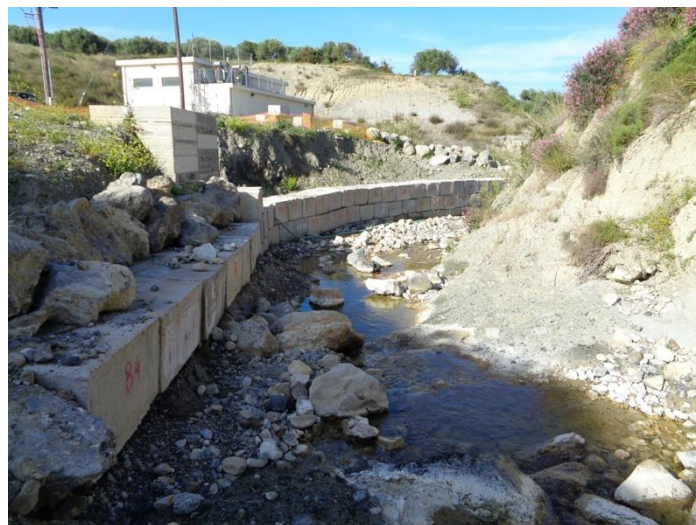
Φ 12. – Τμήμα μεταξύ λεκάνης αποτόνωσης και εξόδου αγωγού εκτροπής
