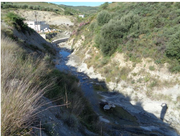
Φ 09. Άποψη πλευρικού ρέματος κατάντη εξόδου υπερχειλιστή
