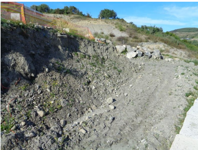
Φ 15. Οδός προσπέλασης προς την κοίτη του ρέματος
