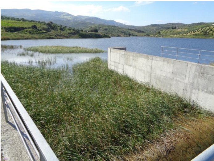
Φ 03. Υπερχειλιστής – Δεξιό αντέρεισμα φράγματος
