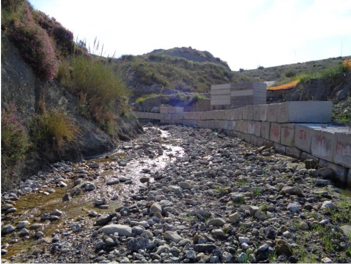
Φ 21. Διευθέτηση υδατορέματος με χρήση τεχνητών κυβόλιθων
