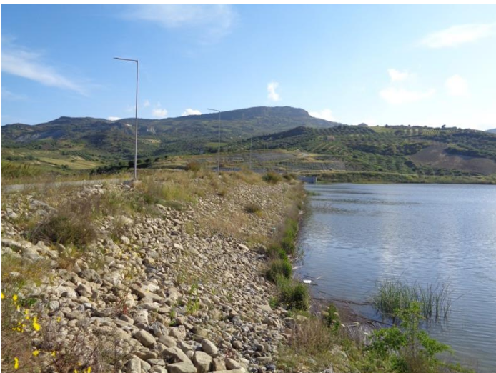
Φ 27. Στέψη του φράγματος
