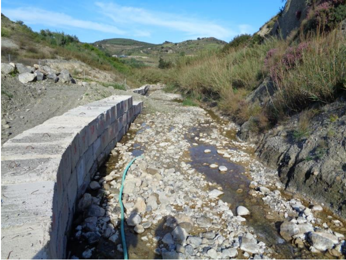
Φ 13. – Τμήμα εκατέρωθεν του αγωγού εκτροπής
