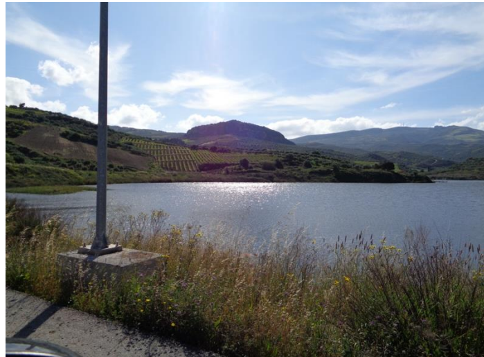
Φ 32. Δεξιό αντέρεισμα ταμιευτήρα – Άποψη από την στέψη του φράγματος
