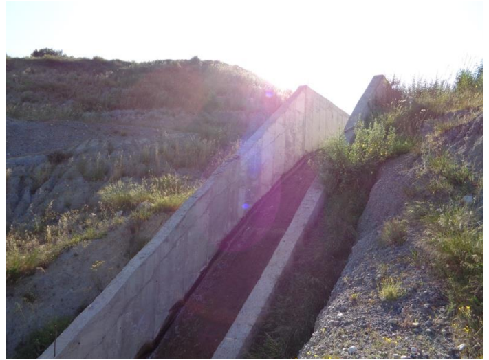
Φ 06. Κεκλιμένη διώρυγα υπερχειλιστή
