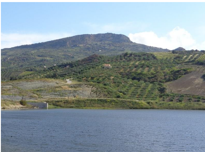
Φ 31. Δεξιό αντέρεισμα φράγματος – Παραλίμνια αγροτική οδός
