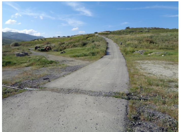
Φ 28. Αριστερό αντέρεισμα φράγματος – Άποψη παραλίμνιων αγροτικών οδών
