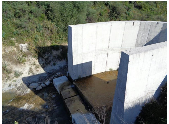
Φ 08. Απόληξη καναλιού υπερχειλιστή
