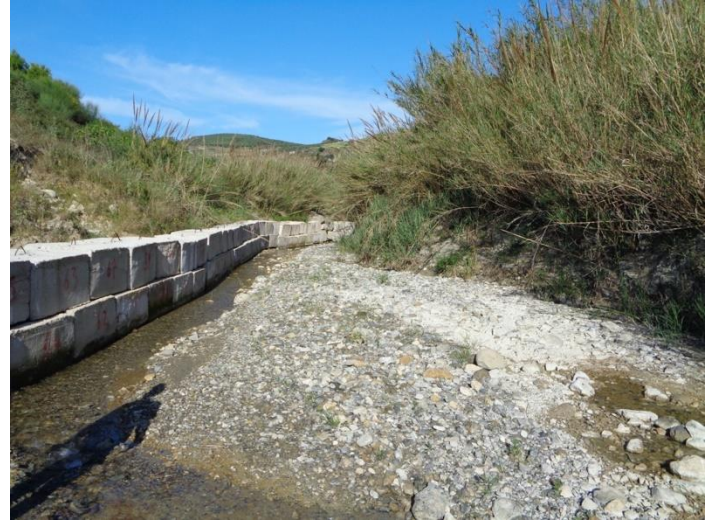
Φ 22. Διευθέτηση υδατορέματος με χρήση τεχνητών κυβόλιθων – Άποψη
