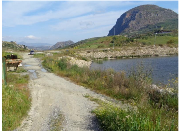
Φ 26. Αριστερό αντέρεισμα φράγματος – Άποψη από αγροτική οδό
