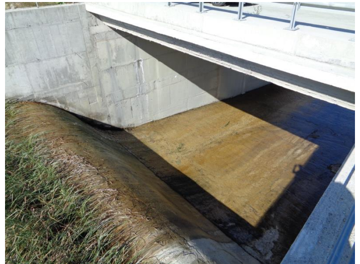
Φ 04. Υπερχειλιστής φράγματος – Άποψη
