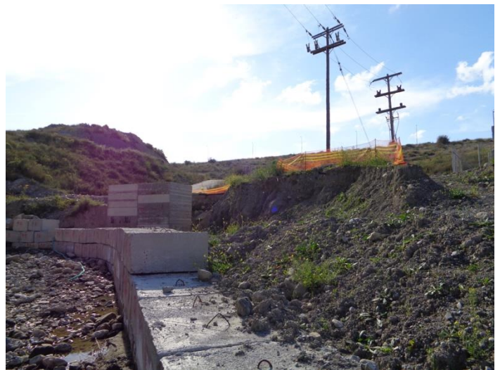
Φ 16. Περιορισμός κατάρρευσης επιχωμάτων με χρήση τεχνητών κυβόλιθων
