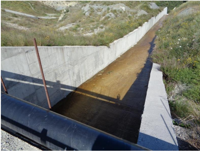
Φ 05. Κεκλιμένη διώρυγα υπερχειλιστή – Άποψη από την στέψη του φράγματος
