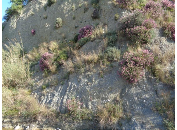
Φ 14. Ρωγματώσεις στο φυσικό πρανές
