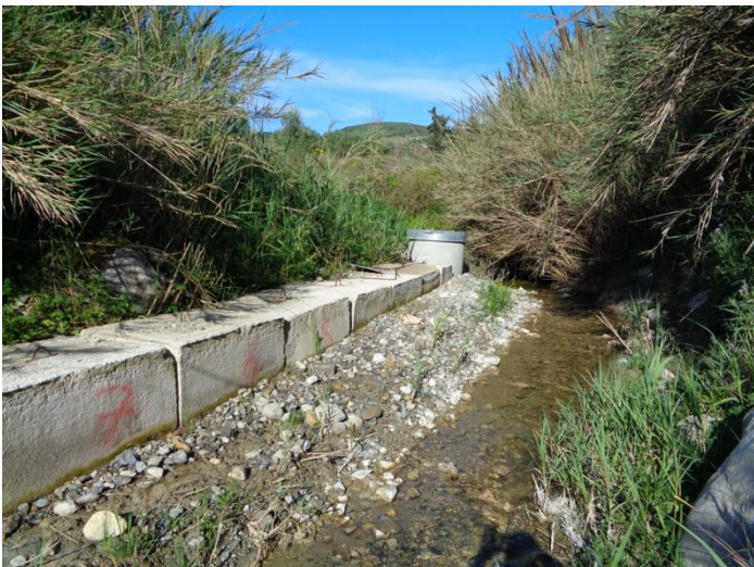
Φ 23. Κατάντη τμήμα ρέματος από την έξοδο του εκκενωτή
