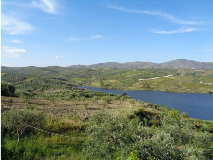
Φ 01. Βορειοανατολική όψη ταμιευτήρα - Άποψη
