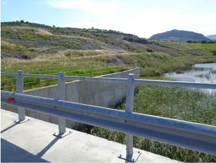
Φ 25. Δεξιό αντέρεισμα φράγματος – Άποψη από την στέψη
